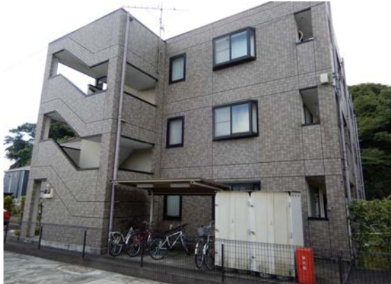
一般外壁： 全景
