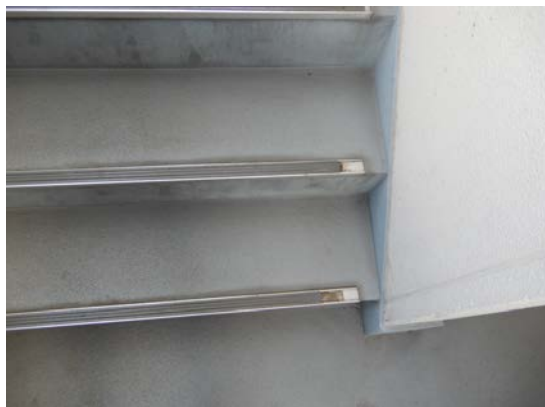
階段床： 汚れ ノンスリップゴムのずれ
