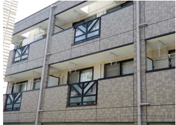
一般外壁： 全景
