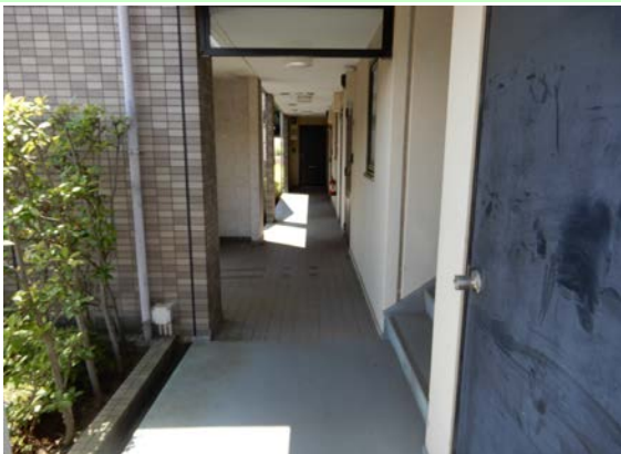
共用廊下： 全景
