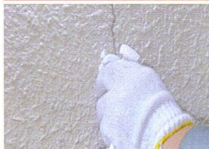
■ 注入充填後、ふきとり清掃仕上げ
