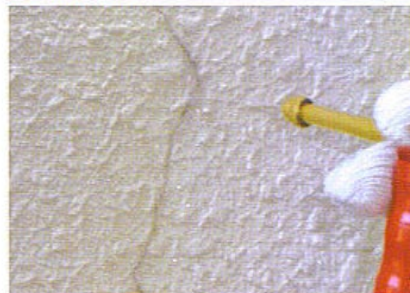
■ ひび割れに対して高圧洗浄を行う内部洗浄
