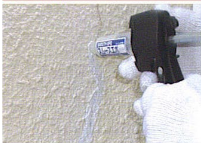
■ ひび割れ注入作業(ハンドスモーター使用)
